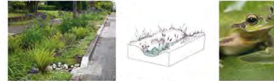
Fossé large et peu profond, à rive en pente douce permettant de collecter les eaux pluviales par ruissellement.
